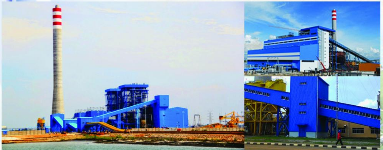
Gambar Proyek PLTU Nagan Raya – Lokasi Desa Suak Puntong Kabupaten Nagan Raya, Nanggroe Aceh Darussalam
