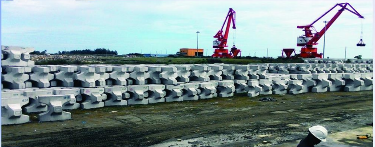
Gambar Proyek Breakwater Improvement – Material Armour Block – Lokasi Desa Suak Puntong Kabupaten Nagan Raya, Nanggroe Aceh Darussalam
