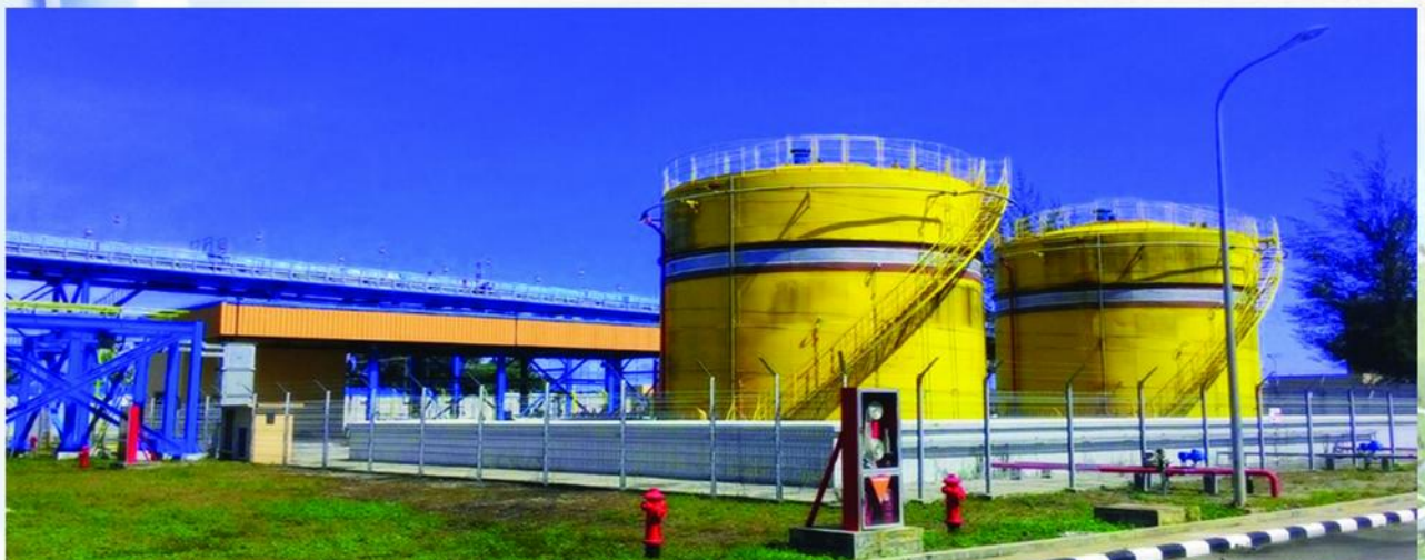
Gambar Proyek Auxiliary PLTU Nagan Raya – Oil Tank AREA – Lokasi Desa Suak Puntong Kabupaten Nagan Raya, Nanggroe Aceh Darussalam
